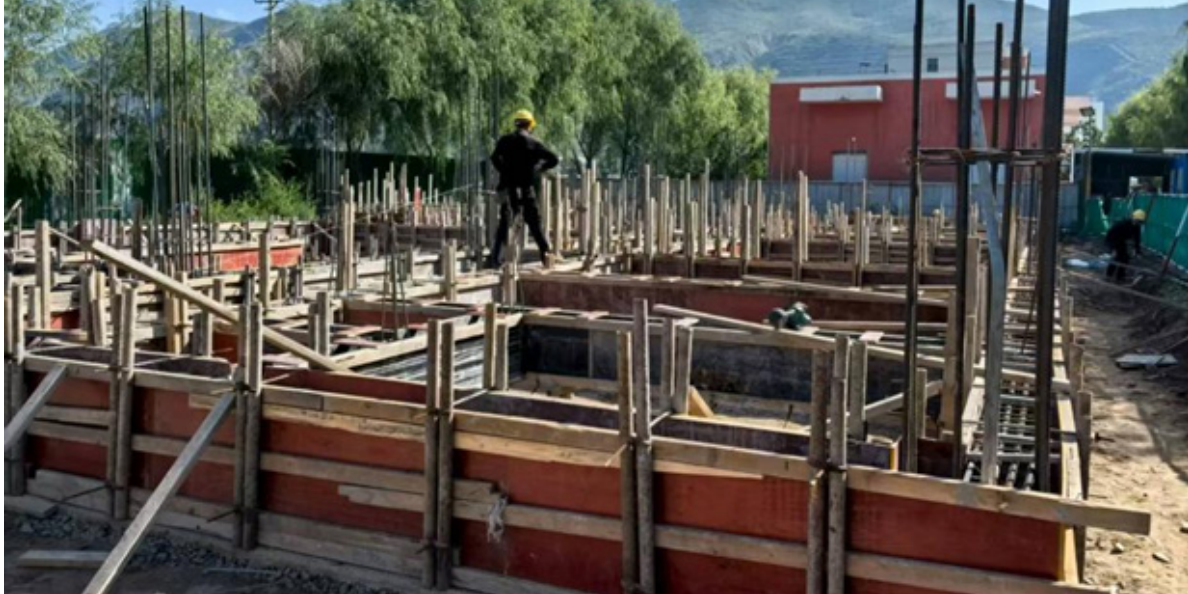
多巴镇清源学校食堂建设
